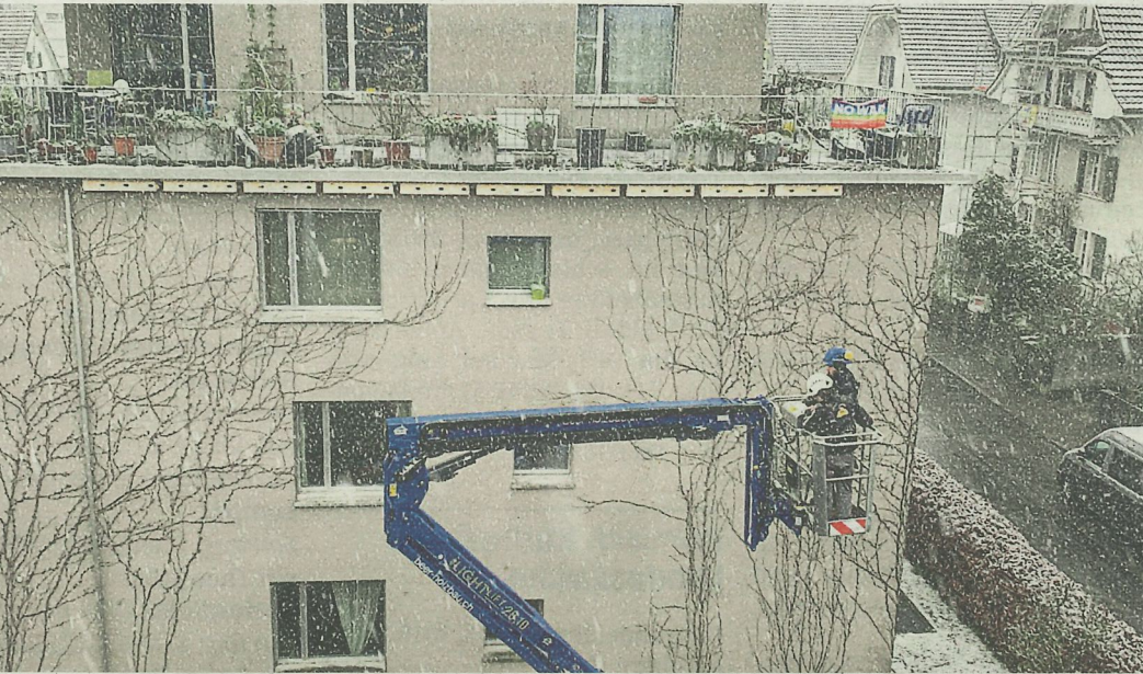
Maflaub und Neal Hirsch von der Beer Holzbau AG, Ostermundigen, fahren mit der Raupenhebebühne hoch und montieren unter dem Dachvorsprung je zehn Nistkästen für die Mauersegler. Foto: Cilgia Schorta
